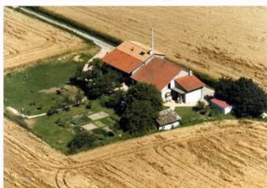
La Preste, maison Delay avant 1996
